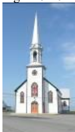
Figure 5.46 L'église et le presbytère de Saint-Maurice
